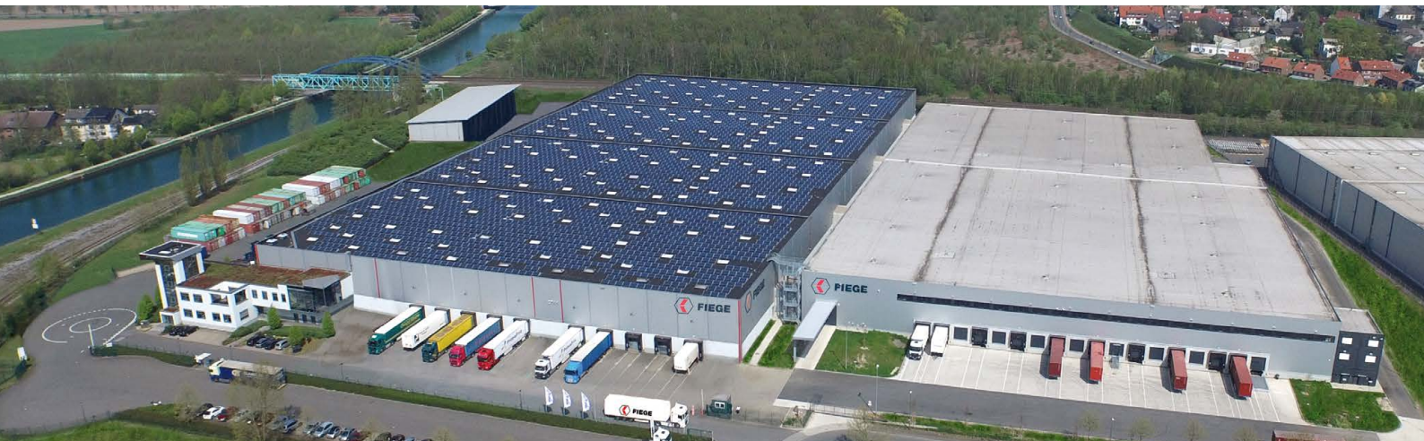
Dortmund – Anlageobjekt ZUKUNFTSENERGIE DEUTSCHLAND 4
