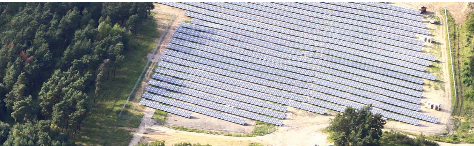
Solarpark Königsbrück – Anlageobjekt SOLARENERGIE 2 DEUTSCHLAND
